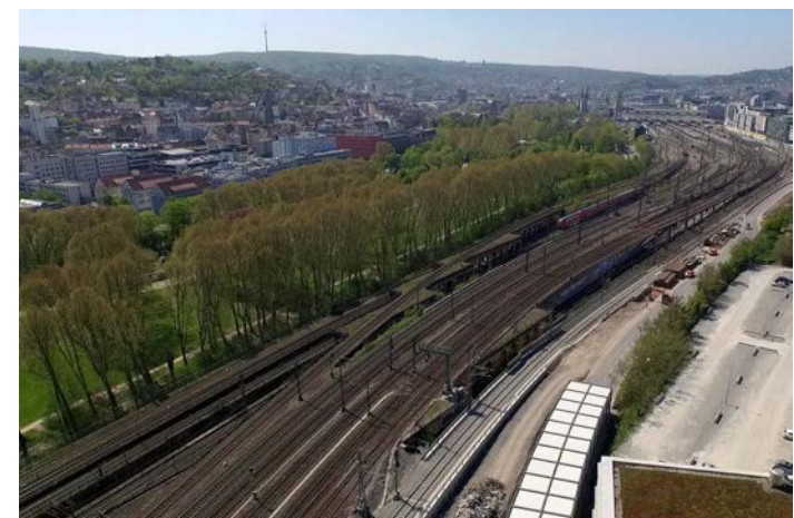
Überführungsbauwerk und Platanenallee
